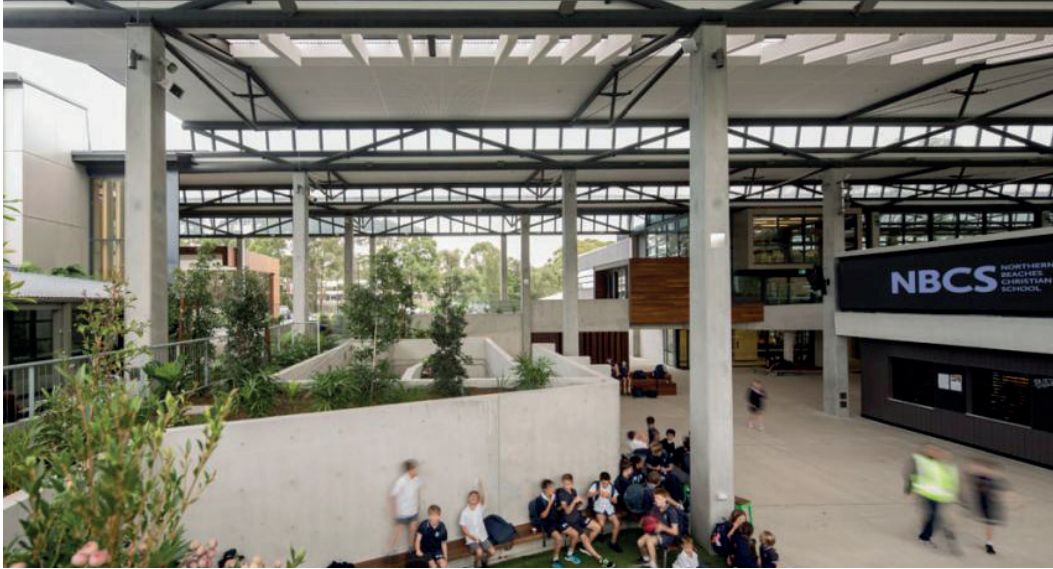
Northern Beaches Christian School réalisée par le cabinet d'architectes WMK
